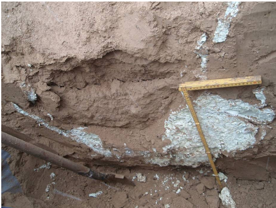
Figura 18, expansión de la resina en el área circustante el punto de inyección
