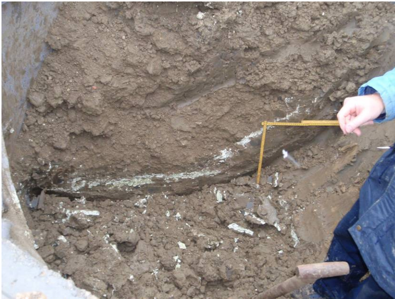
Figura 13, expansión del material de inyección en el tegel
