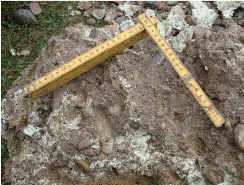
Figura 7, mezcla de grava y resina Uretek Geoplus®
