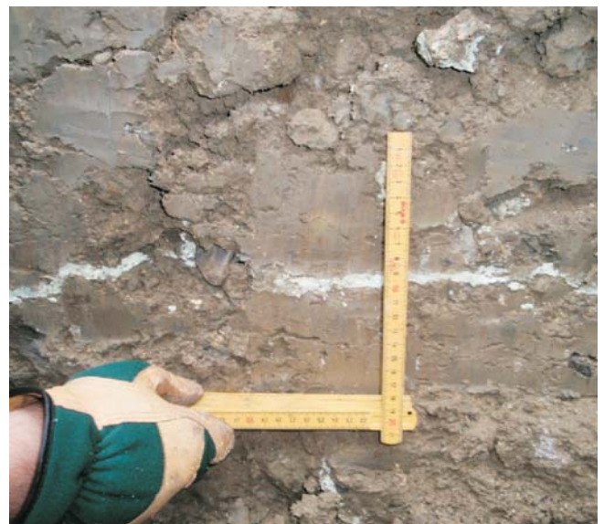
Penetración de la resina para rellenar las grietas de contracción y compactación
