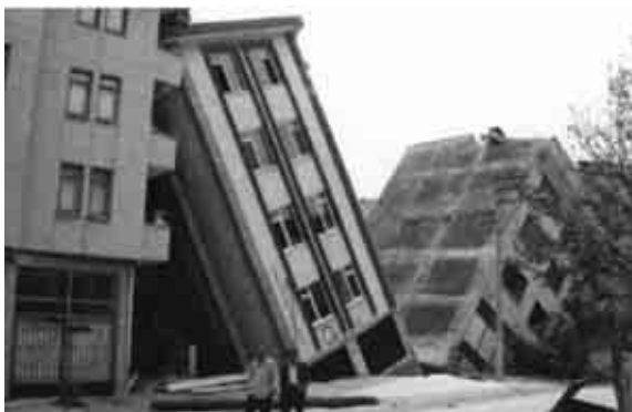
FIGURA 1. EJEMPLOS DE FRACTURAS POR SUPERACIÓN DE LA CAPACIDAD PORTANTE DE CIMENTACIONES SUPERFICIALES EN ADAPAZARI.
