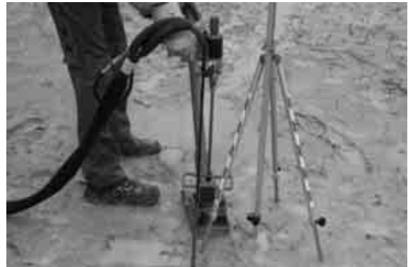
FIG. 17: EJECUCIÓN DE UNA INYECCIÓN Y CONTEMPORÁNEAMENTE EXTRACCIÓN DE LA LANZA
