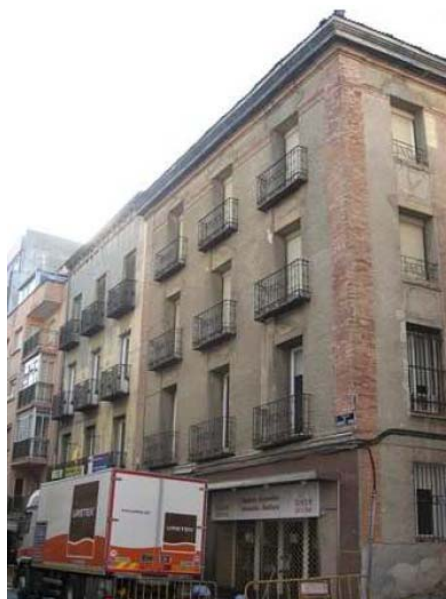
Figura 40. Vista del edificio durante la actuación.
