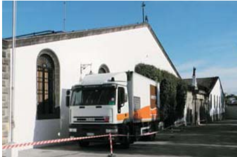
Figura 46. Vista de la bodega durante la actuación.
