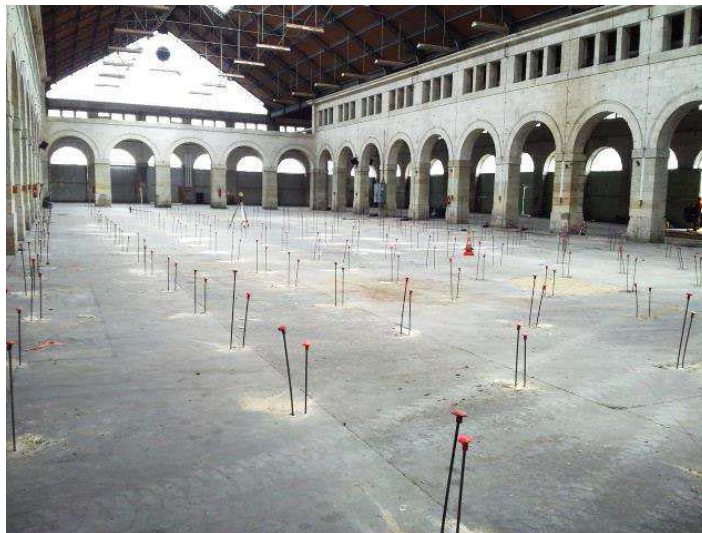
Figura XX. Malla con los tubos de inyección en una losa.
