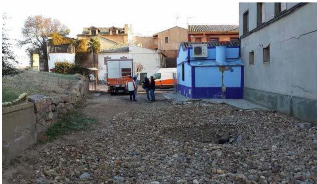
Figura 53. Vista de la edificación y de la dolina creada.
