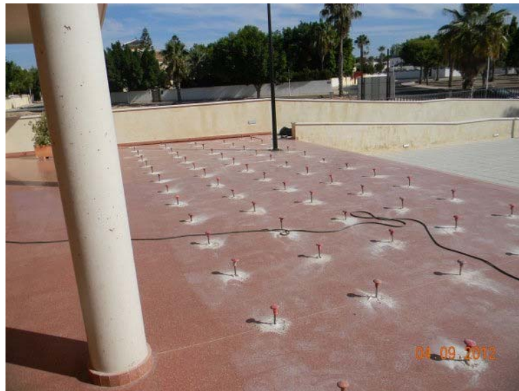
Figura 50. Distribución de los puntos de inyección sobre el pavimento exterior.
