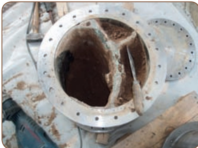
■ Figura 4.2. Resina solidificada en el interior de las fracturas propagadas en el terreno arcilloso, vista desde el fondo del troquel
