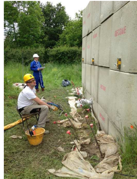
Foto 3[b]. Inyección del segundo nivel bajo el control del láser permanente.
