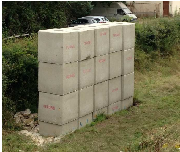
Foto 1. Estado de la estructura antes de las inyecciones
