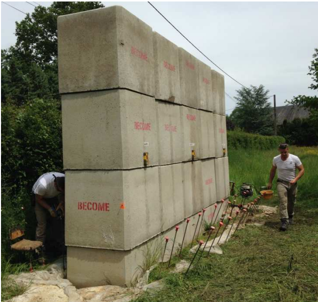
Foto 3[a]. Preparación de la inyección del primer nivel.
