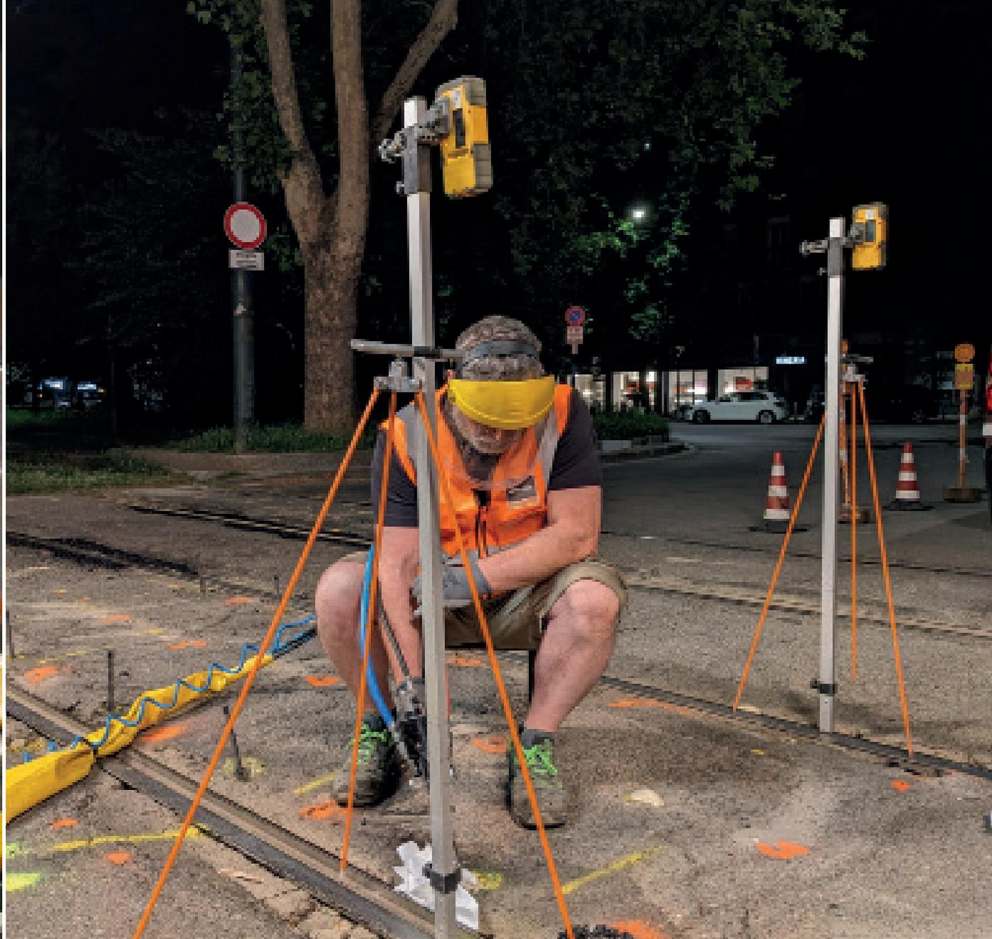
**Iniezione della resina e monitoraggio del principio di sollevamento della rotaia.**
