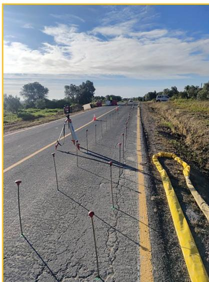
Fig. 7. Posa in opera delle cannule Multipoint, secondo la maglia di progetto
