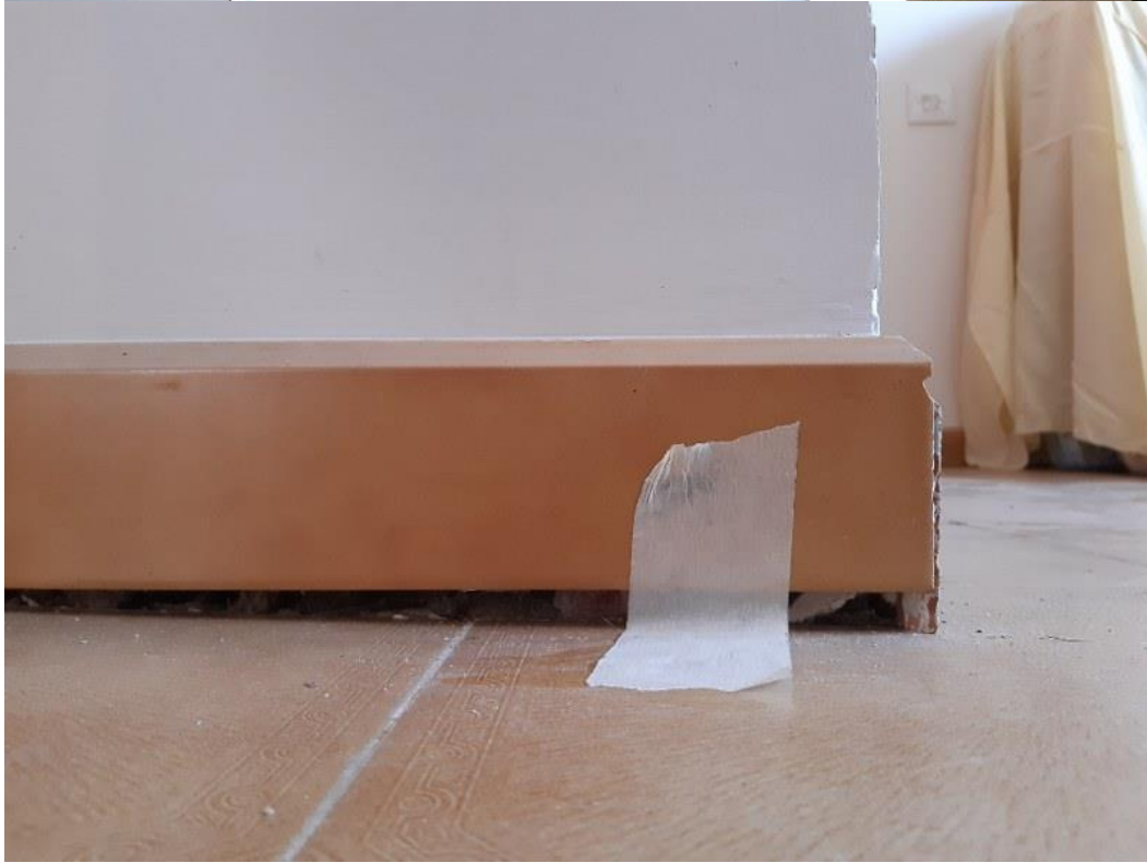
HUNDIMIENTO SOLERA
