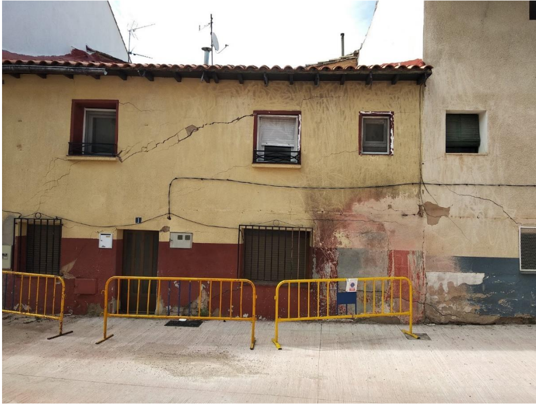
ARCO DE DESCARGA
