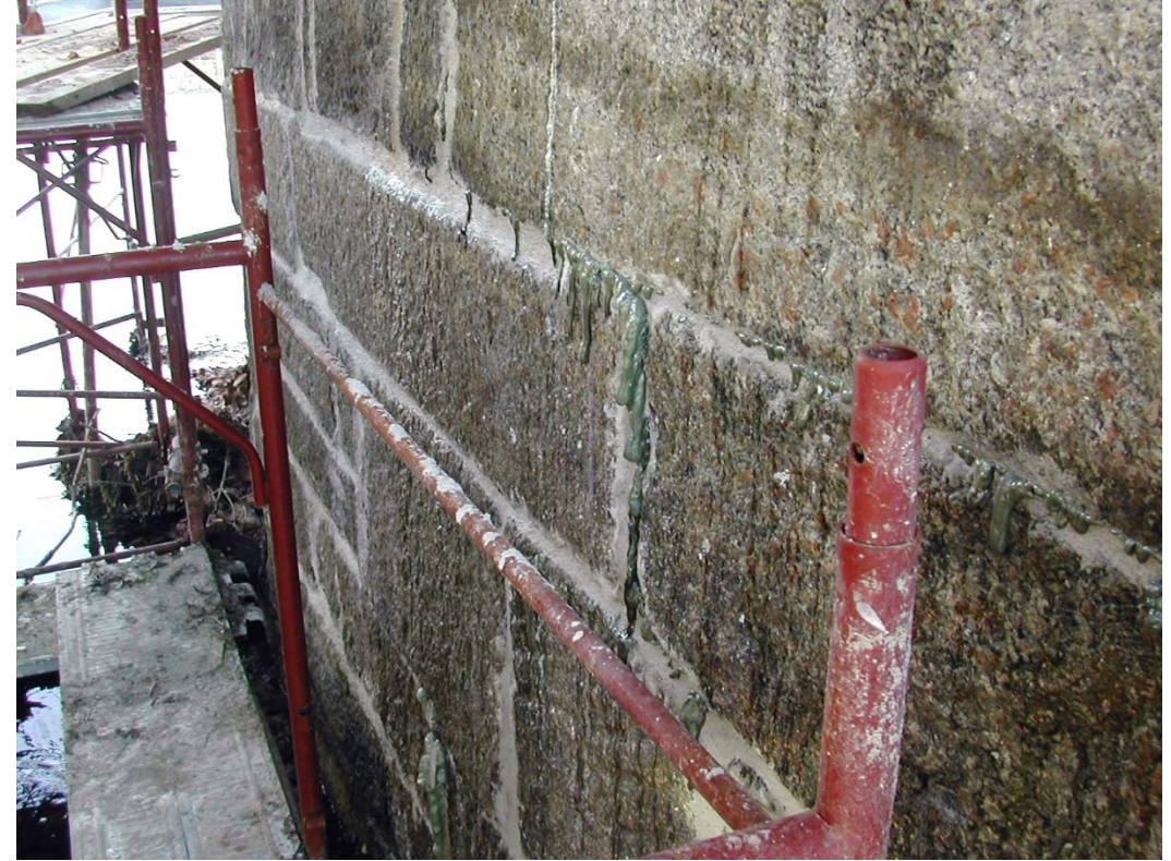
RESTABLECIMIENTO DEL CONGLOMERANTE DE MAMPOSTERÍA
