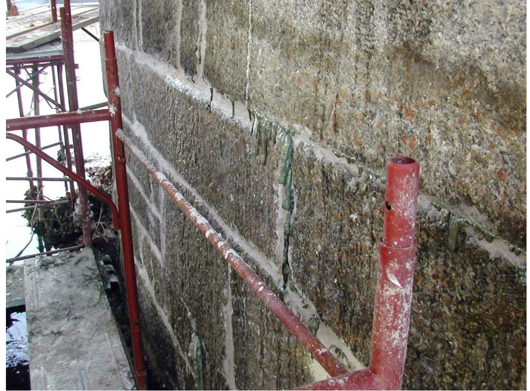
RESTABLECIMIENTO DEL CONGLOMERANTE DE MAMPOSTERÍA
