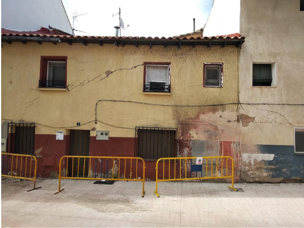
ARCO DE DESCARGA
