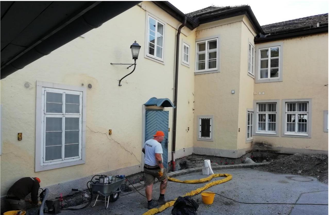
Abbildung 2-3: Für die Injektion der Harze an der Vorderseite aufgedigter Bereich
